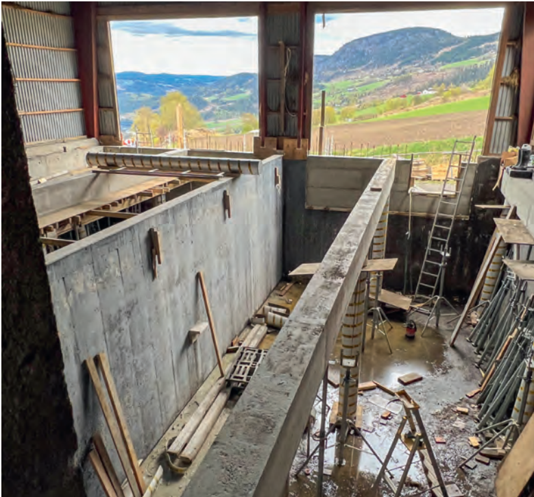
Plansiloene bygges om til fjøs med 8 liggebåser, fôrbrett og melkerobot.
