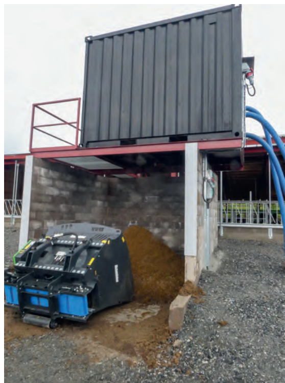
Gjødsel fra kufjøset går innom en gjødselseparator før det ender i den gamle gjødselkummen. Separert gjødsel brukes som strø i fjøset og legges ut med spesialmaskinen på bilde.
