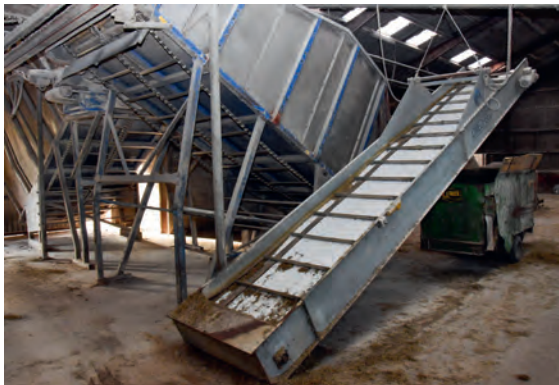
Erik Møller Andersen har et automatisert One2Feed fôringsanlegg der den skinnegående mikservogna fylles med de fôrslagene som inngår. Det er 13 ulike komponenter som veies og fylles i vogna før blanding. Foto: Rasmus Lang-Ree
