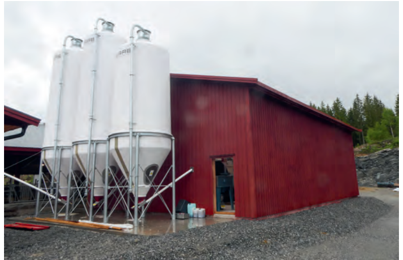
Martin Dahlin har bygd en førsentral for One2Feed-føringsssystem vegg i vegg med nyfjøset. Der kan en fylle opp rundballer og plansilo for tre dager på to ulike matere.
